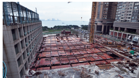
擴校工程五月份施工進度
