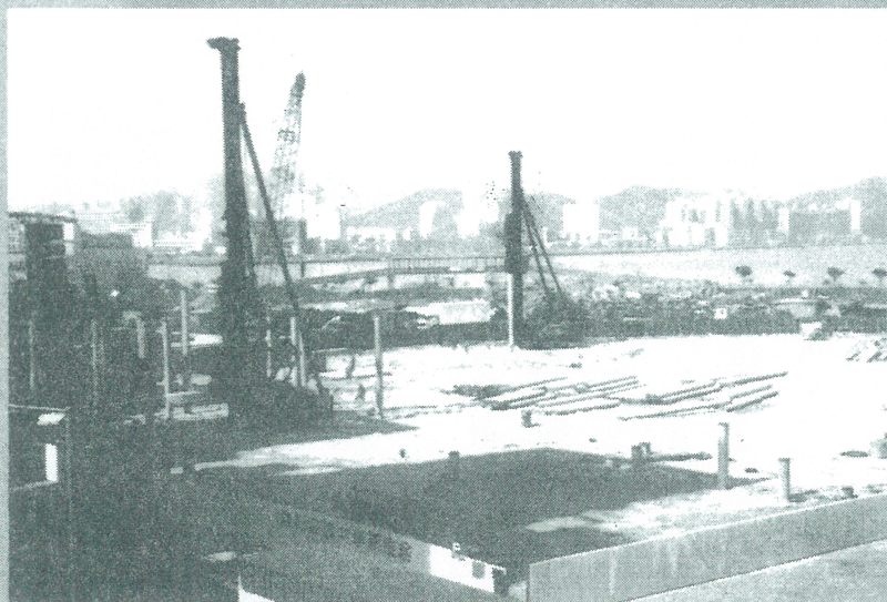
新校舍的打樁工程接近完成，相片遠處是拱北一帶的景色。
